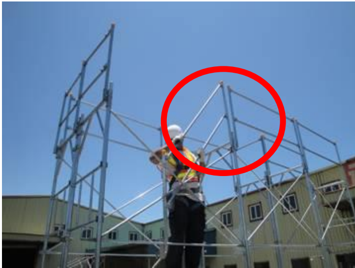
設置推進式先行扶手框
