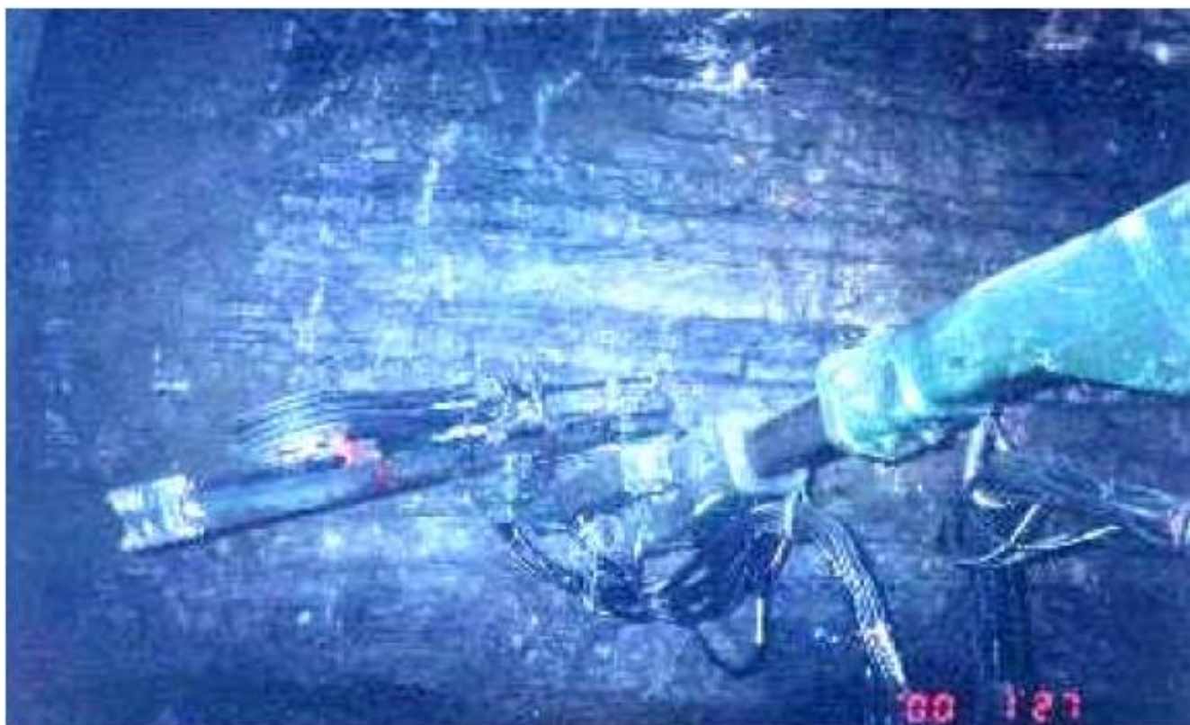
新奧工法隧道施工開炸孔鑽設作業
