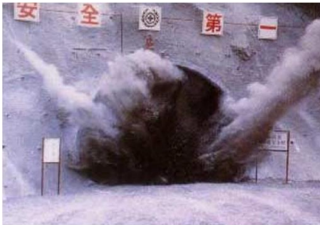
新奧工法隧道施工之開挖面開炸
