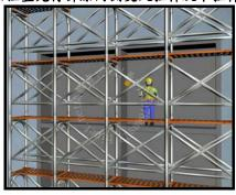
3. 循施工架上下設備到達欲拆除位置之下一層施工架工作 台(到達定位後立即將安全帶妥為掛置)。
