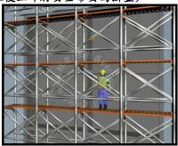
4. 拆除外側交叉拉桿後放置於下拉桿處(外側下拉桿不拆)。
